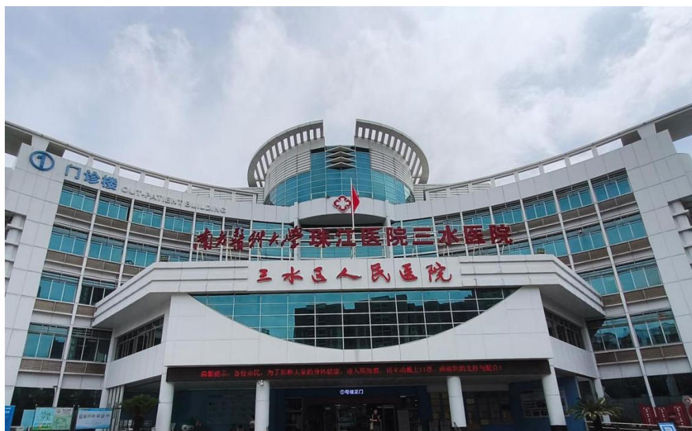
图2-4 门诊楼外立面实景
