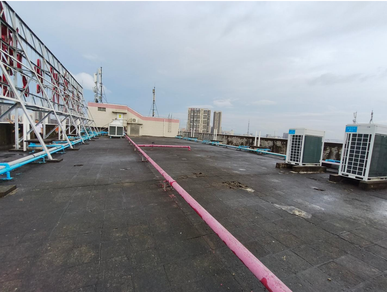
图2-8 住院楼屋顶实景
