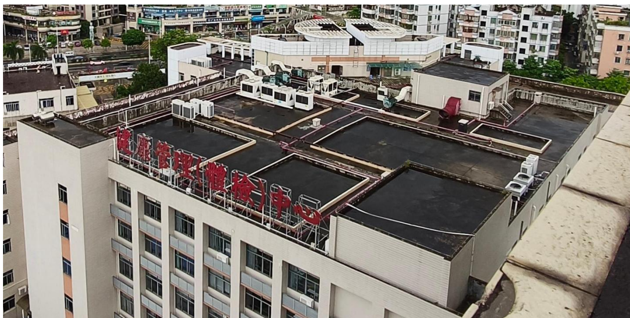
图2-7 科研楼屋顶实景
