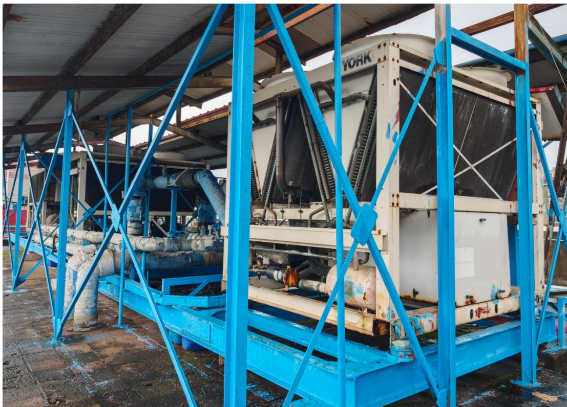
图 6-14 风冷热泵机组
